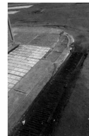
En la calle de Aldama, haciendo esquina con la calle de Acuña, se detectó una rejilla para cableado fuera de su lugar, el piso en mal estado y una barda de aproximadamente 15 centímetros de altura formando un cuadrado y dentro de él una profundidad de casi medio metro, el cual representa un grave peligro para los transeúntes, siendo más susceptibles a sufrir un accidente las personas con discapacidad visual que no les permita detectarlo a tiempo.
