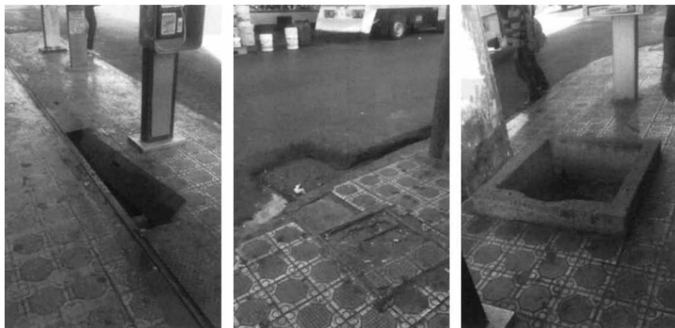
En la calle de Xicotécatl entre Aldama y Pérez Treviño se observan varias tapas de cemento en mal estado, con agujeros, así como varias tapas de cemento que sobresalen del nivel normal de la banqueta y registros abiertos.
