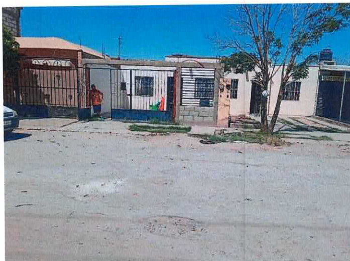
1. Falta cuadro de medido
